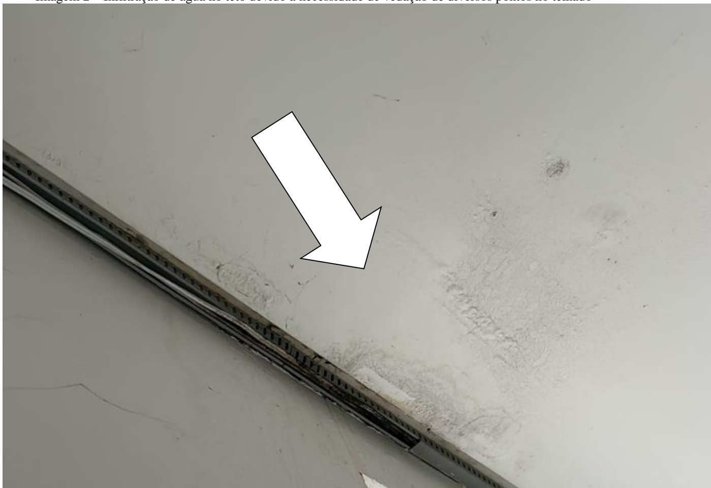
Imagem 2 – Infiltração de água no teto devido a necessidade de vedação de diversos pontos no telhado
