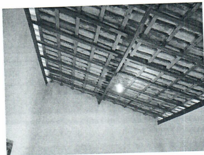
Imagens do local onde será instalado o forro PVC.
