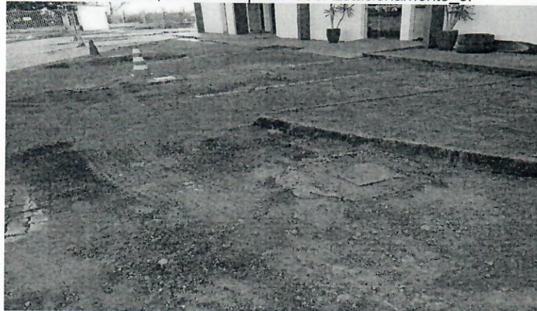
Foto 5: Det. estacas, blocos e sapatas Cob. Estacionamento 3.
