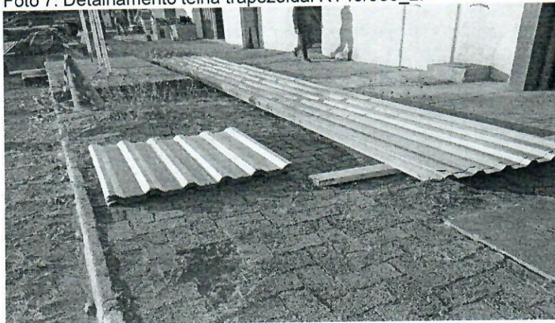
Foto 7: Detalhamento telha trapezoidal RT40/980_2.
