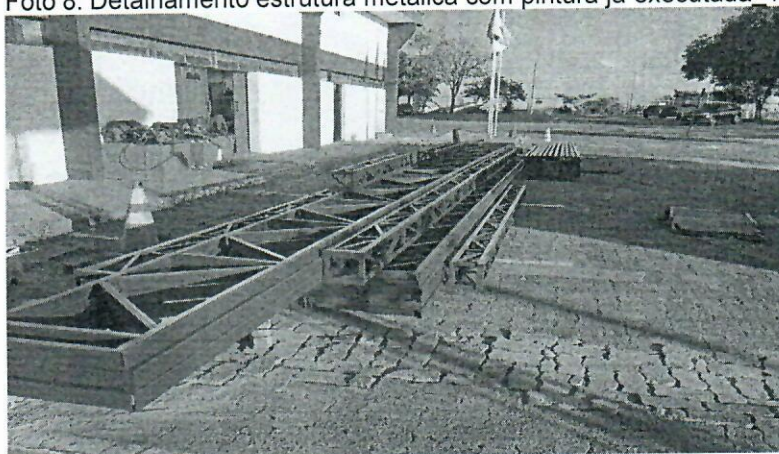
Foto 8: Detalhamento estrutura metálica com pintura já executada 1.
