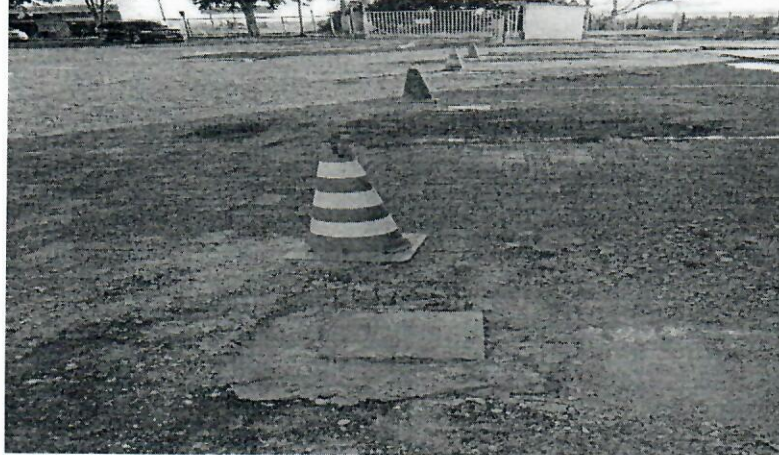
Foto 4: Det. estacas, blocos e sapatas Cob. Estacionamento 2.
