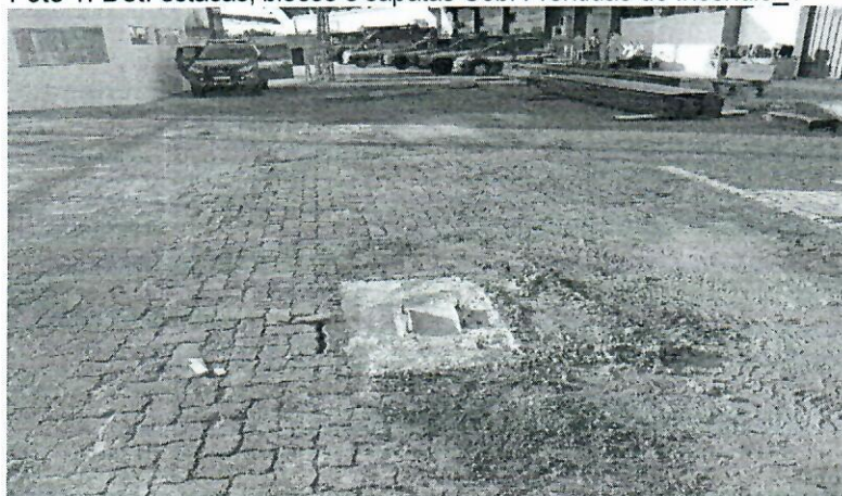
Foto 1: Det. estacas, blocos e sapatas Cob. Prontidão de Incêndio_1
