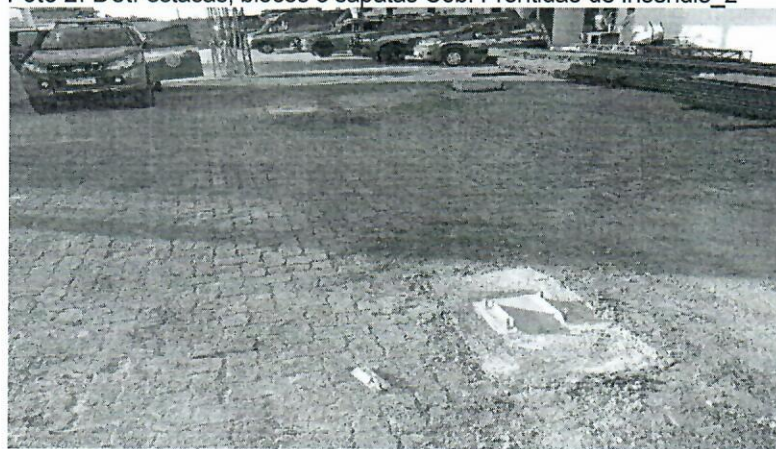
Foto 2: Det. estacas, blocos e sapatas Cob. Prontidão de Incêndio_2
