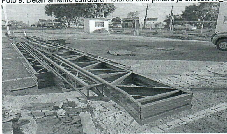
Foto 9: Detalhamento estrutura metálica com pintura já executada 2.
