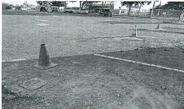
Foto 3: Det. estacas, blocos e sapatas Cob. Estacionamento_1
