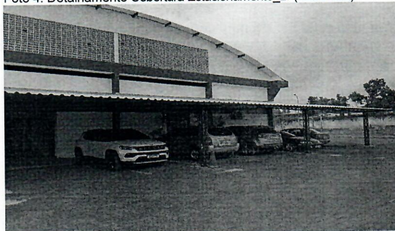
Foto 4: Detalhamento Cobertura Estacionamento_2. (finalizada)
