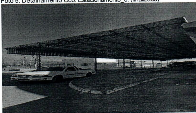
Foto 5: Detalhamento Cob. Estacionamento_3. (finalizada)
